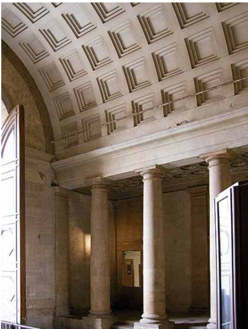
Свод центрального прохода
